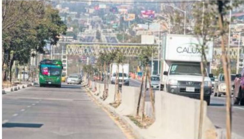
PERIFÉRICO. La rehabilitación y mantenimiento de esta vía, una prioridad.
