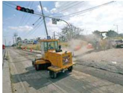
Vialidad. Las obras se realizarán en diferentes etapas para no colapsar la movilidad. / CORTESÍA
