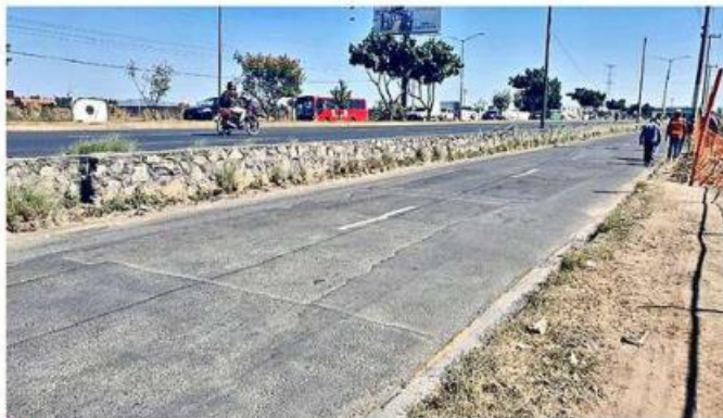
■ Ayer comenzaron las obras de rehabilitación en los carriles laterales norte y sur de la Avenida Juan Gil Preciado.
