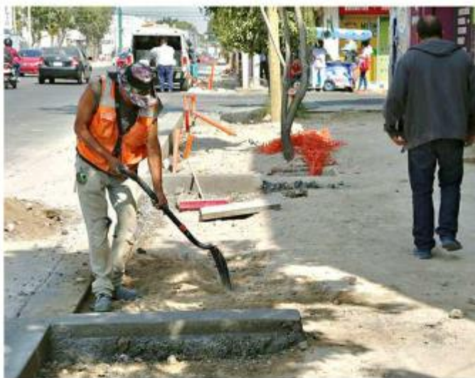
■ En la Av. Enrique Díaz de León, en el tramo de Alemania a Niños Héroes, se trabaja en las banquetas.
