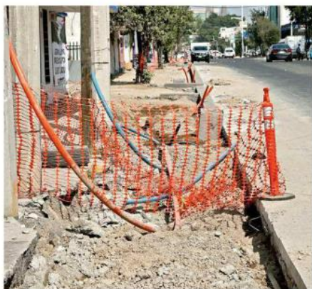
■ Aún falta concluir la introducción de ductos y cableado.
