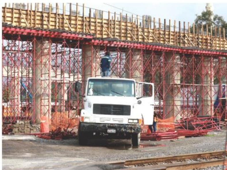
Alfaro Ramírez dijo que esta obra estará lista y funcionando a finales del 2024.
