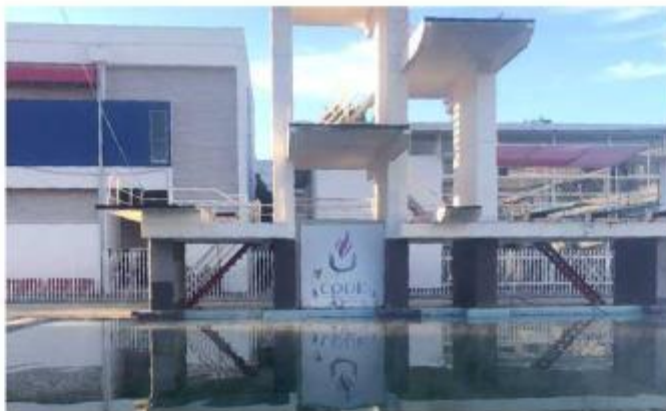
■ La función de los servidores públicos señalados, está relacionada con el área de albercas.
