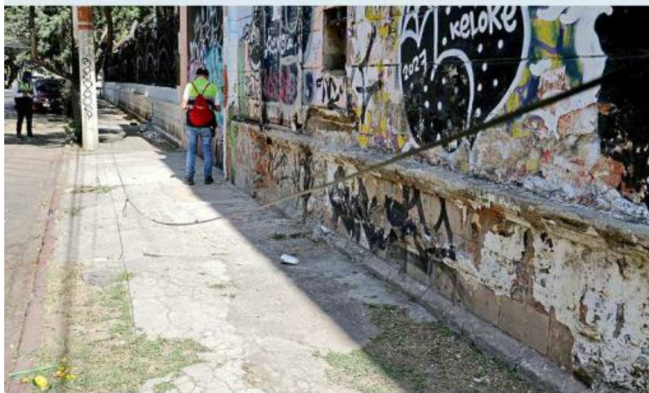
La Canieti rechazó dar la razón al Municipio sobre el cableado.
