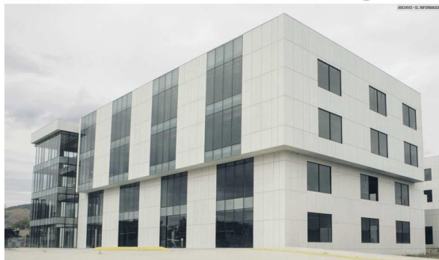
EN PROCESO. Las obras del nuevo Instituto Regional de Cancerología debieron estar terminadas en diciembre del año pasado.
