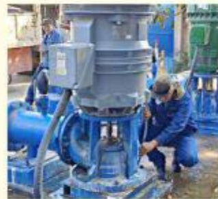
■ Se intervinieron 14 estaciones de bombeo, 11 de agua potable y 3 de agua cruda.
