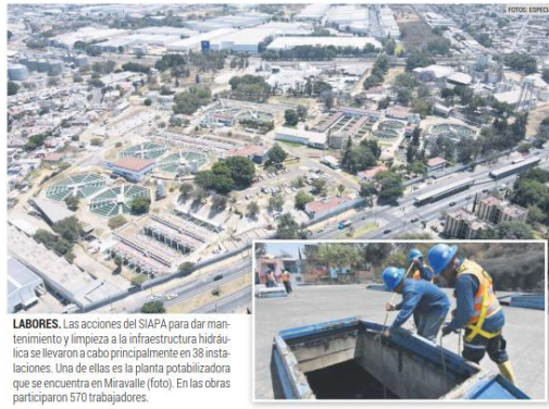
LABORES. Las acciones del SIAPA para dar mantenimiento y limpieza a la infraestructura hidráulica se llevaron a cabo principalmente en 38 instalaciones. Una de ellas es la planta potabilizadora que se encuentra en Miravalle (foto). En las obras participaron 570 trabajadores.
