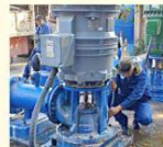
■ Se instalaron 14 estaciones de bombeo, 11 de agua potable y 3 de agua cruda.
