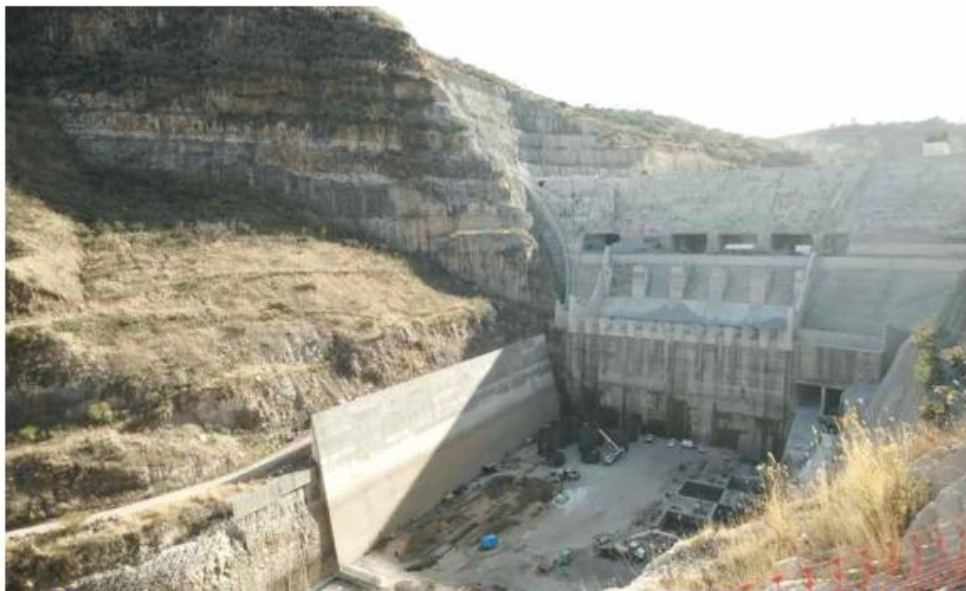
PENDIENTE. La empresa española obtuvo la concesión del acueducto que llevaría el agua de la Presa El Zapotillo a León, Guanajuato, pero no lo construyó.
