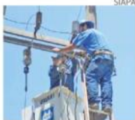
SIAPA terminó trabajos.
