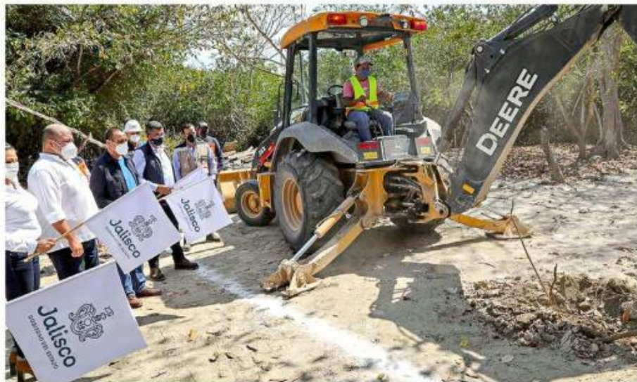
Las obras en el Estero El Salado comenzaron en mayo del 2021.
