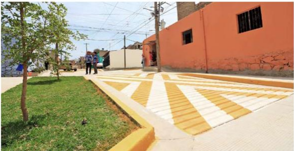
Se instaló concreto hidráulico y empedrado en jal.
