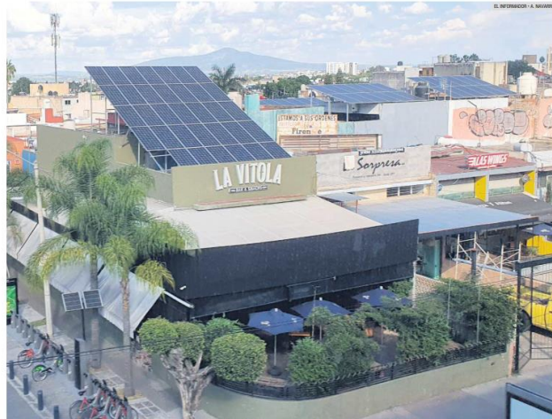
SE HACEN VER. Cada vez es más común observar en las azoteas de la ciudad más paneles solares, tanto en zonas habitacionales como en comercios.
