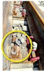
En la imagen queda evidenciada la falta de sujetadores en los rieles.
