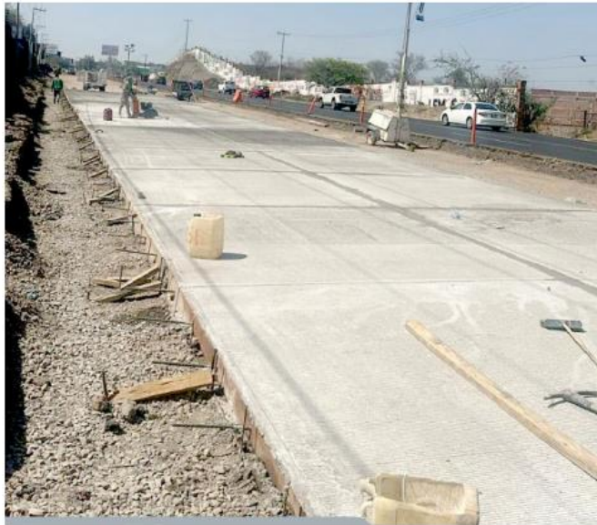
Se colocó concreto en tres carriles.
