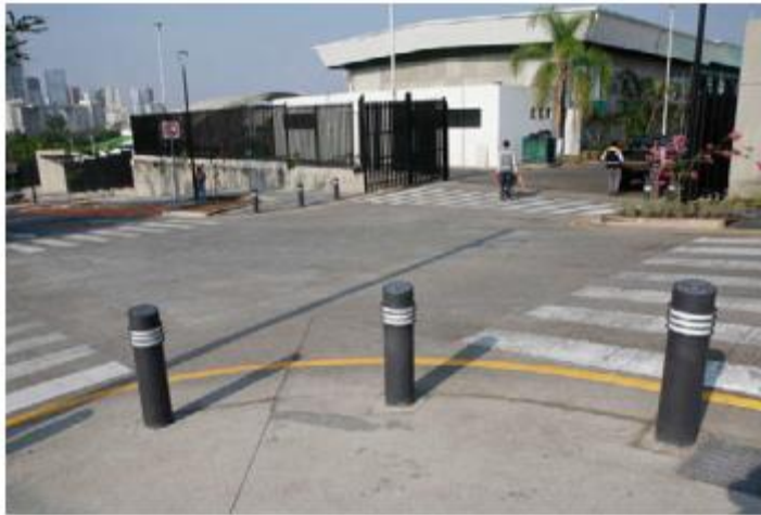
OBRAS. El gobierno de Zapopan entregó la renovación de la calle Santa Laura, en las inmediaciones de la colonia Lomas del Bosque y Real del Parque. Invirtieron más de 26 millones de pesos.
