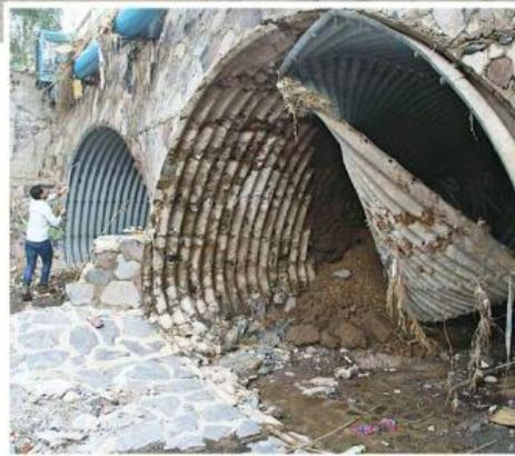
■ El cárcamo de un puente ubicado sobre el Arroyo Seco se desprendió, generando el socavón.
