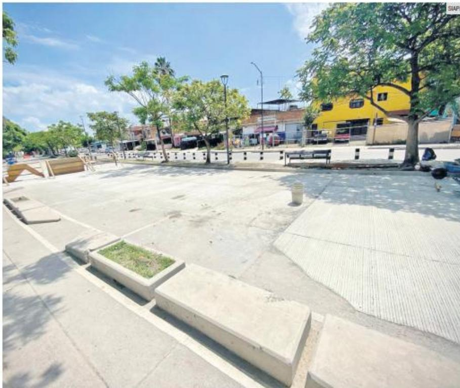
El Sistema Intermunicipal de los Servicios de Agua Potable y Alcantarillado (SIAPA) informó que, tras el colado total de la superficie de rodamiento, concluyeron los trabajos de reparación en el primer socavón que se registró en la Avenida Malecón.
