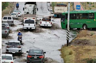
■ Santa Cruz del Valle es uno de los puntos que ha padecido por inundaciones en la zona de la Avenida Adolf B. Horn.
