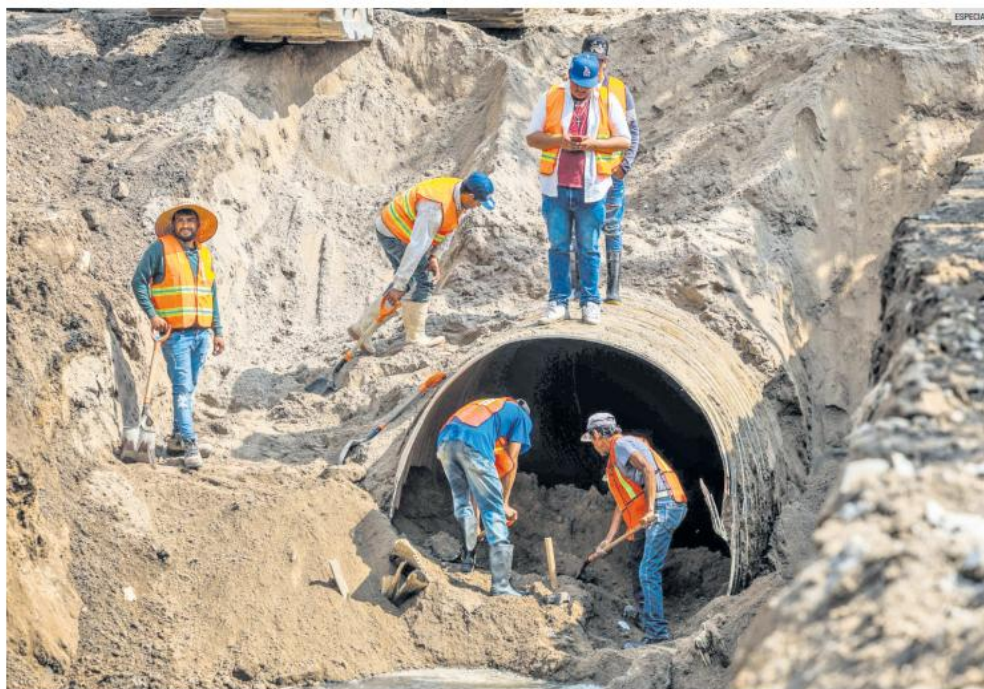
RIESGO. Trabajadores del SIAPA realizan reparaciones en un socavón en una zona del Oriente de Guadalajara, donde las redes de drenaje tienen hasta 90 años de antigüedad y presentan un alto riesgo de colapso por falta de mantenimiento.
