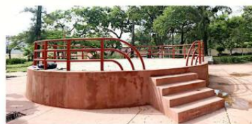
Uno de las piezas características del Parque es el kiosco y ya está prácticamente terminado.
