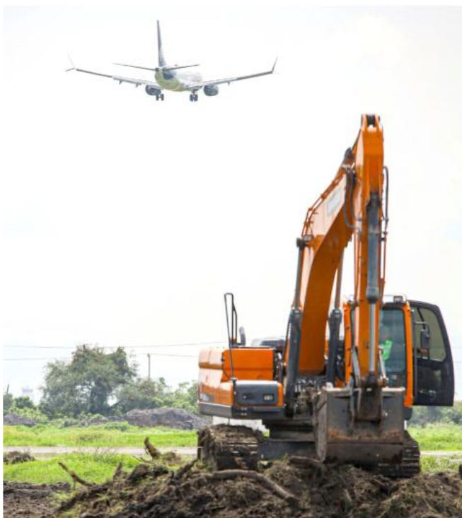
Además, la obra desahogará el tráfico carretero para el ingreso a Guadalajara.
