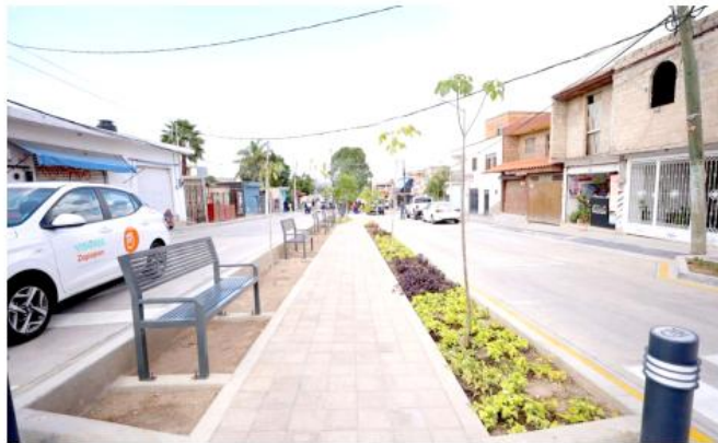
La rehabilitación de la avenida Mezquitán incluyó la renovación de redes hidráulicas y sanitarias.
