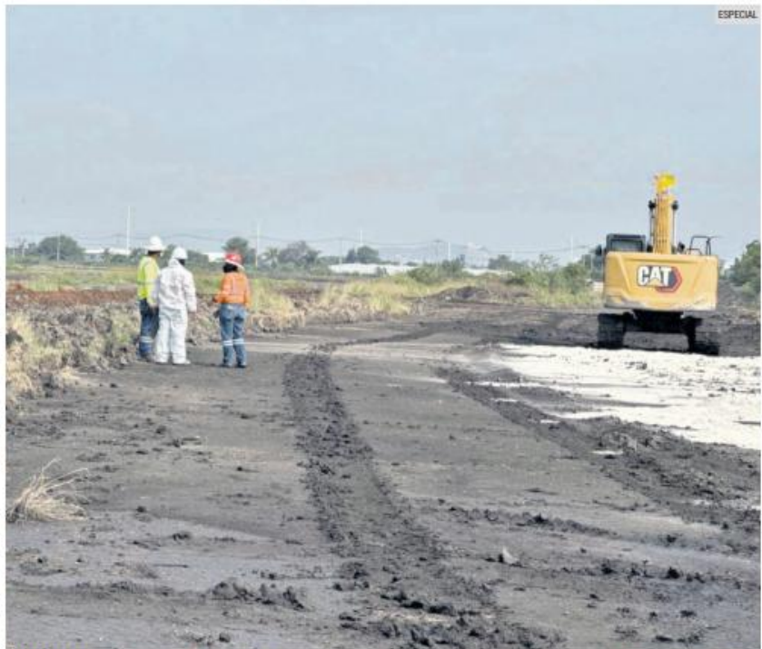
OBRAS. Maquinaria pesada prepara el terreno en los primeros metros del nuevo acceso vial al Aeropuerto Internacional de Guadalajara.
