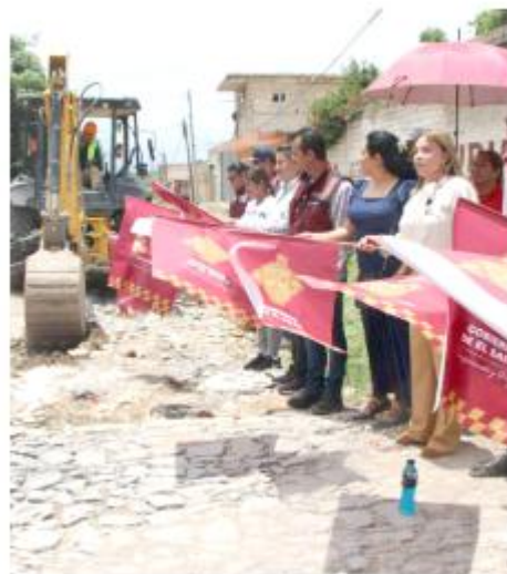
Nena Farías, dio el banderazo de arranque de las obras.
