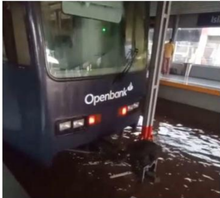
La estación Isla Raza de la Línea 1 del Tren Ligero quedó completamente inundada tras la lluvia de este miércoles. ESPECIAL
