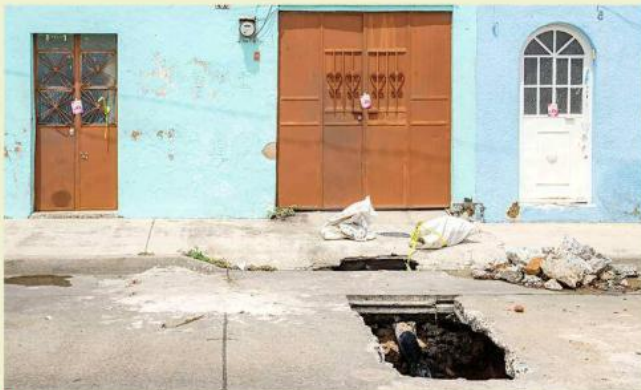
Personal del Siapa labora en un bache ubicado en Secundina Gallo entre Aurelia Guevara y Vicente Negrete.
