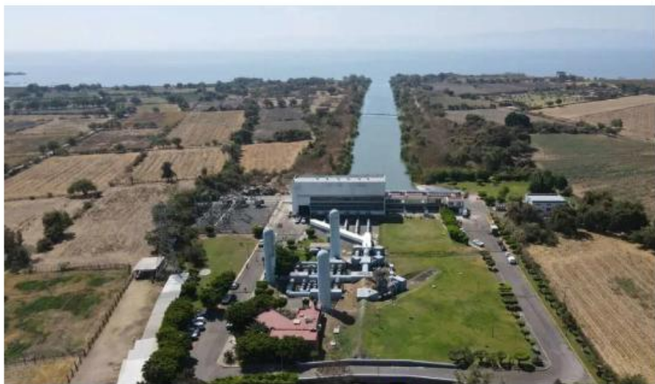
El acueducto actual abastece un 60 por ciento de agua al AMG. ESPECIAL
