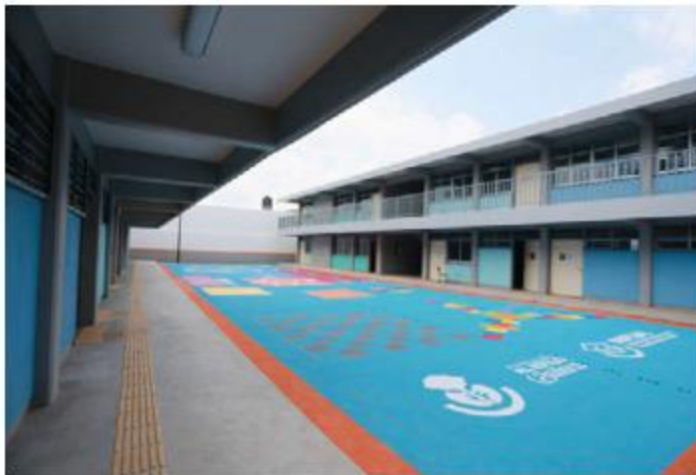
OBRA. Entregaron la renovación de la Primaria 15 de Mayo ubicado en Los Tulipanes de Tlajomulco, como parte del programa Escuelas con Estrella. Invertieron 28.5 millones de pesos.
