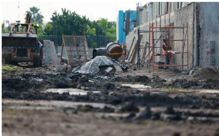
Está a tres minutos del fraccionamiento abandonado. ESPECIAL
