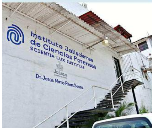
■ Al nuevo edificio de Puerto Vallarta le agregarían un área de identificación humana.
