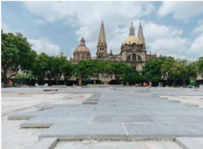
**OBRAS.** La rehabilitación en la Plaza Liberación tiene un avance del 45 por ciento; se concluyó la impermeabilización y se colocan las losas de concreto.
