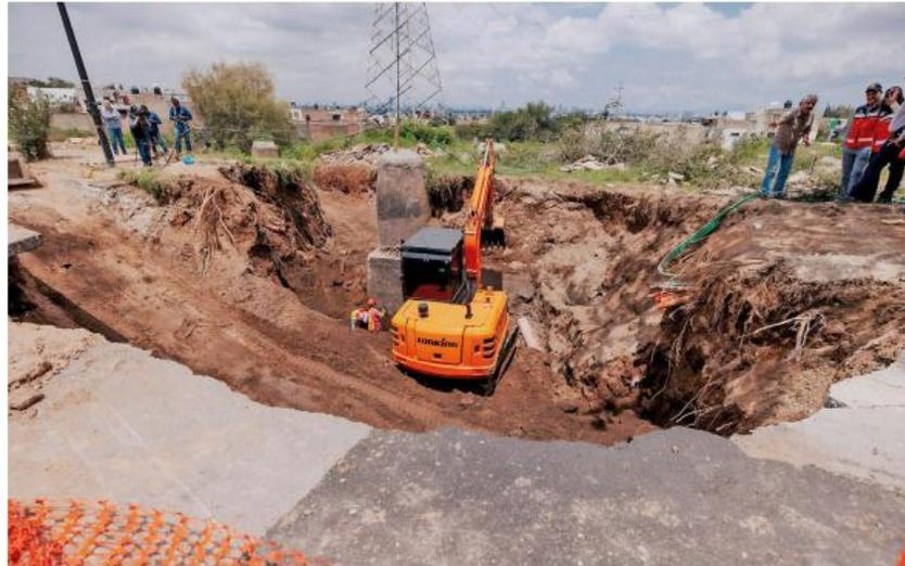
un muro de contención, realizar el relleno y compactación del terreno, reemplazar las líneas de agua potable y drenaje, y, finalmente,
