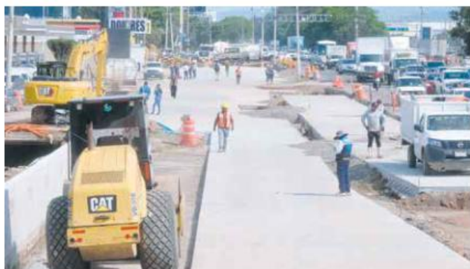
FALTAN. Las obras de la L5 ya iniciaron en la carretera a Chapala pese a que aún no están listos los estudios costo-beneficio y del modelo financiero del proyecto.
