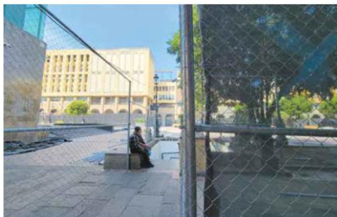
HACE POCO. Los trabajos en Paseo Hospicio comenzaron la semana pasada.
