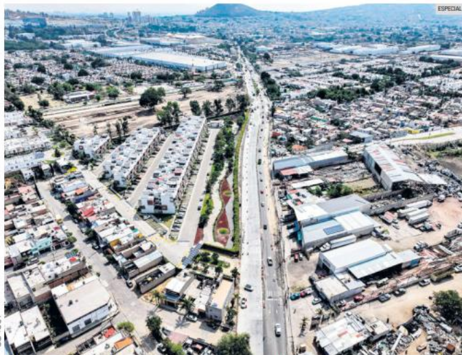
AVANCE. La reapertura del tramo de Camino Real a Colima, entre Ramón Corona y Guadalupe Gallo, permite la circulación en ambos sentidos y mejora la movilidad hacia el Sur. Es una alternativa a López Mateos.
