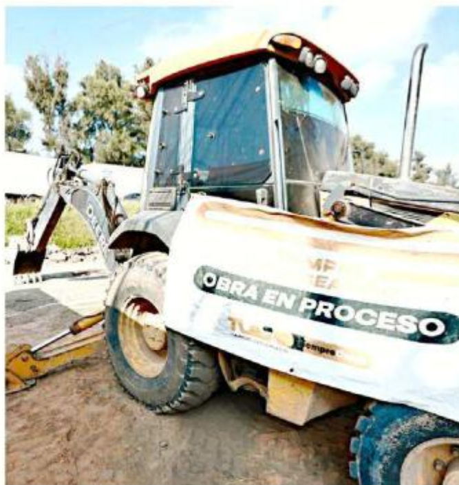
■ La línea llevará agua de la planta potabilizadora de El Zapote a la localidad de El Refugio.
