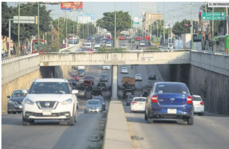
OBRAS. Vista de la avenida Juan Gil Preciado antes del inicio de las obras de mejora vial y reencarpetamiento.
