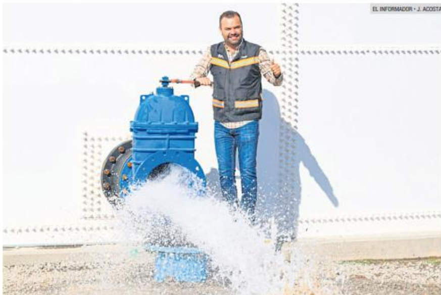
PLAN. Con los tanques gigantes y la Planta Potabilizadora Número 5, el alcalde Gerardo Quirino Velázquez avanza en su compromiso con las familias de la Zona Valle, al garantizar agua para 130 mil habitantes.
