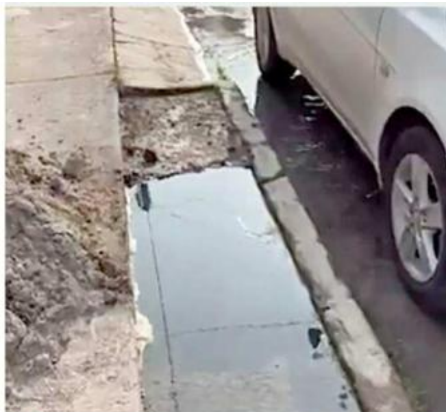
■ La fuga en la Calle Lago Catemaco tardó una semana en repararse, y eso porque la queja llegó al Gobierno del Estado.
