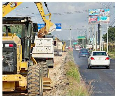
■ Entre las obras que ya iniciaron en Zapopan está la repavimentación de Juan Gil Preciado.
