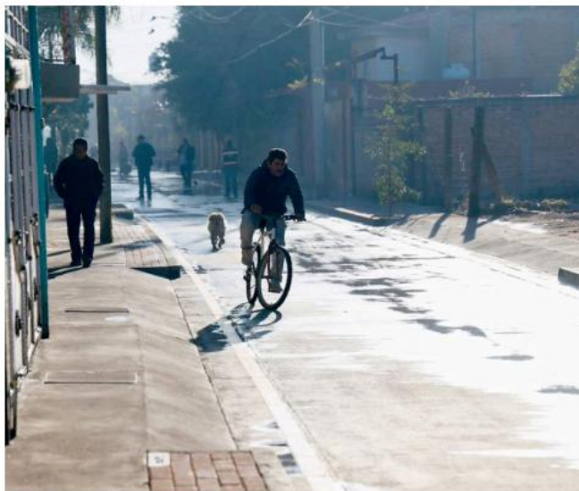
La obra incluyó 210 metros lineales de pavimentación con concreto hidráulico.
