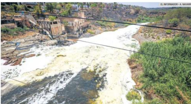
PROBLEMA. Las descargas de aguas residuales en el Río Santiago no han tenido una solución integral.
