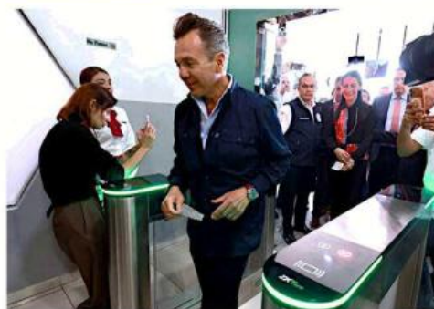
■ En los andenes de la Central se instalaron torniquetes para tener mayor control de quienes viajan.
