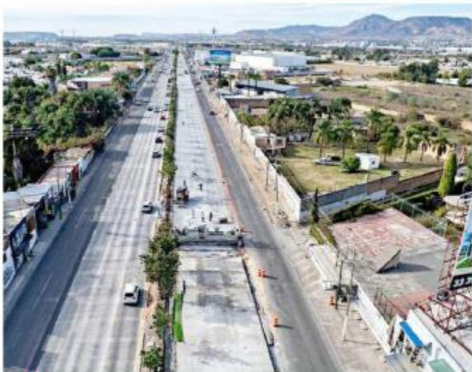
■ La primera etapa de la obra incluyó la rehabilitación de los carriles centrales con concreto hidráulico.
