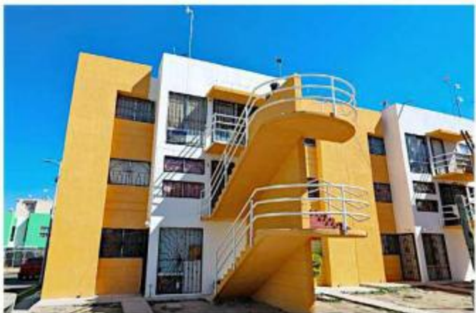
■ Se rehabilitaron en total 562 viviendas en Lomas del Mirador y Chulavista, en Tlajomulco.
