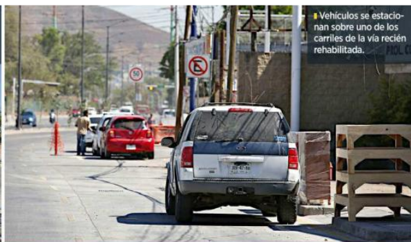
■ Pese a que las obras debieron concluir en diciembre, aún hay trabajos pendientes.
