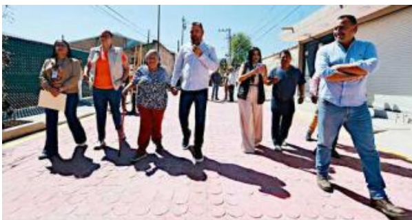
■ La remodelación de la Calle Aguirre Sur, en Tlajomulco Centro, constó de renovación de concreto, drenaje banquetas y bolardos.
