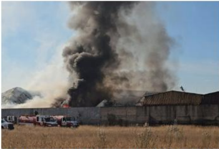
INCENDIO. Fábrica de gelatinas se consumió por completo en Tlaquepaque, hubo varias explosiones al interior y bomberos de toda el AMG acudieron al lugar. No se reportan lesionados.
