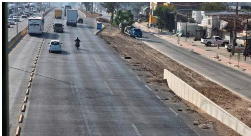
El proyecto contempla adecuaciones viales para permitir el acceso eficiente de las unidades del sistema, además de la construcción de un puente peatonal.
