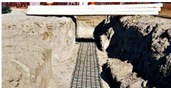
■ Se comenzó la perforación de un pozo profundo en el área de Punto Sur, sobre el corredor López Mateos.
