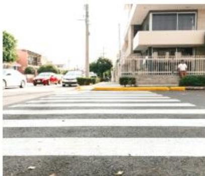
La inversión para la obra fue de 4.2 millones de pesos.
