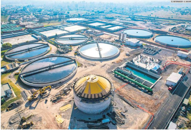
SAANEAMIENTO. Las Plantas de Tratamiento de Aguas Residuales Agua Prieta y El Ahogado (en la imagen) operan por debajo de su capacidad, lo que limita el saneamiento del Río Santiago.
