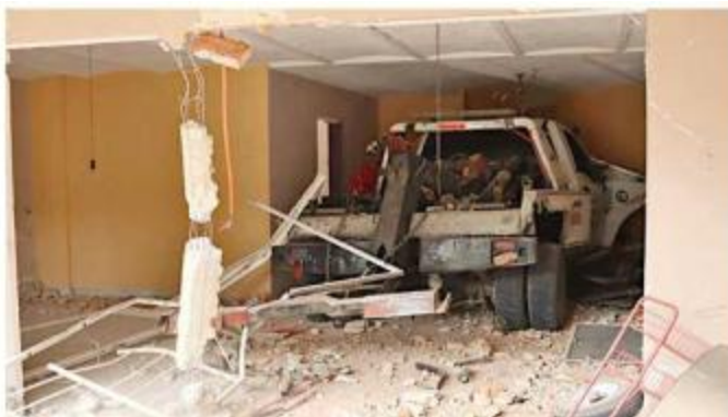
Los sujetos se quedaron a vivir en la casa de Emma Quijada tras el accidente de una grúa.
