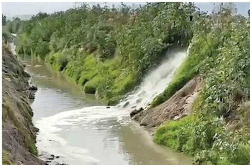
El agua turbia que llega a colonias del AMG, obedecería a fugas que se registran en este arroyo.
