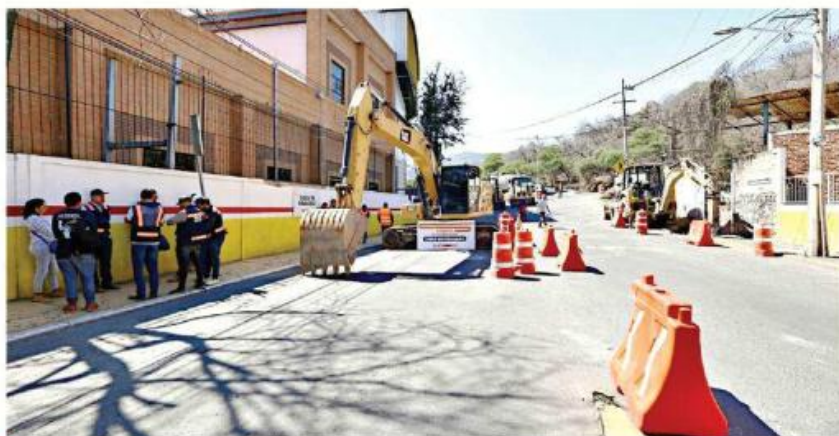
■ La obra será en la Calle Juárez Sur, que albergará el Paseo de la Rosa.
