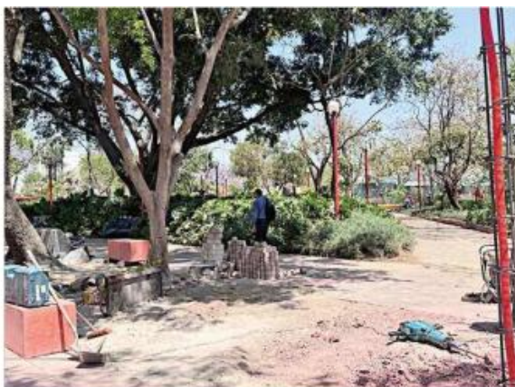
■ Las obras de remodelación del Parque Rojo ya casi cumplen un año; estaban previstas para durar 5 meses.
