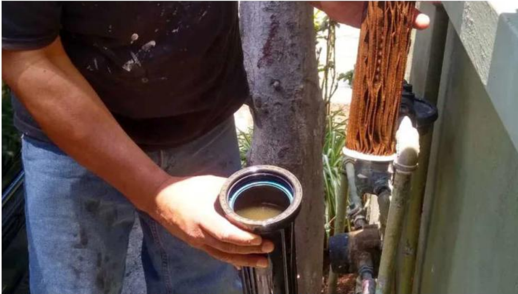
El mal olor no se queda en las tuberías, se impregna en la ropa, en el organismo y en los espacios. MILENIO
