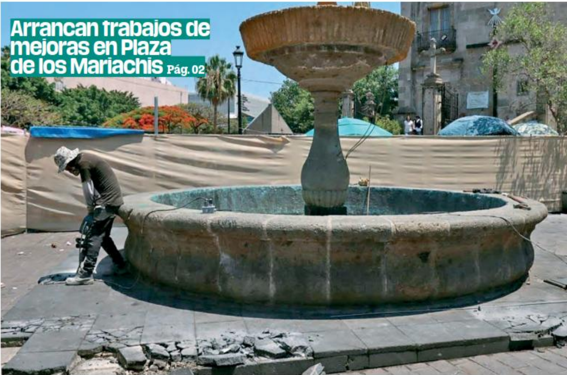
Proyecto. La intervención en el espacio contempla la rehabilitación de infraestructura, luminarias y portales. /CORTESÍA
