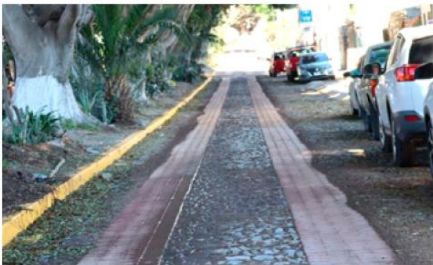
Contemplan la reconstrucción integral de calles, renovación de redes de agua potable y drenaje.
