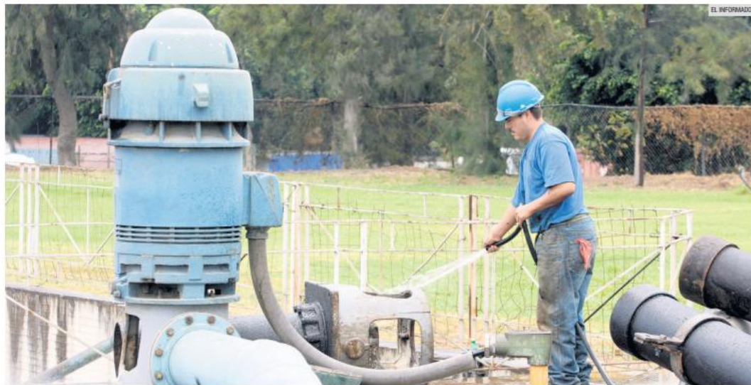
URGENCIA. Darle un mantenimiento y limpieza a las plantas potabilizadoras del SIAPA es prioridad para mitigar la turbiedad del agua.
