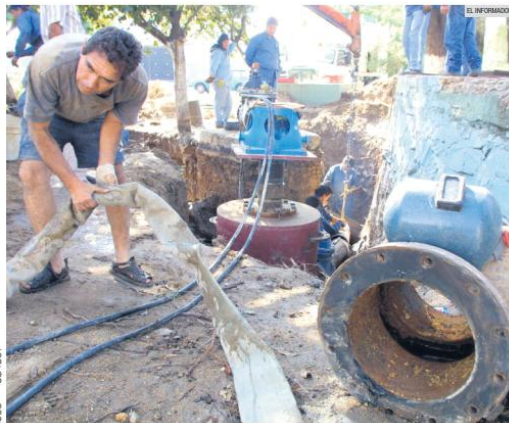
OBRA PRIORITARIA. Trabajadores realizan labores de mantenimiento en la red hidráulica, infraestructura que el Gobierno de Jalisco busca sustituir con el proyecto del Acueducto II Chapala-Guadalajara.
