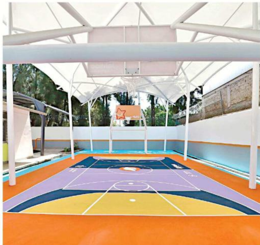
■ Ayer se entregaron las obras de remodelación del Centro de Atención Múltiple de San Juan de Ocotán, en Zapopan.
