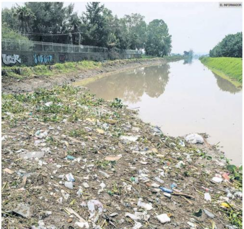
SUCIEDAD. El canal de Las Pintas forma parte del sistema de abastecimiento de agua para la ciudad.
