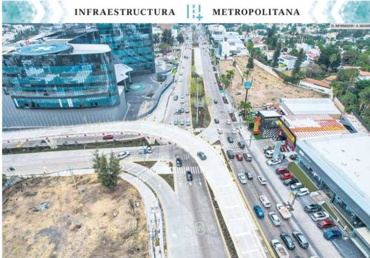
PATRIA Y UNIVERSIDAD. El paso elevado mejora la conectividad y reduce los tiempos de traslado. Incorporó banquetas con accesibilidad universal, cruces seguros, ciclovia conectada, paradas de transporte público y semaforización inteligente. Es un modelo integral a favor de la población que vive o cruza por la zona.
