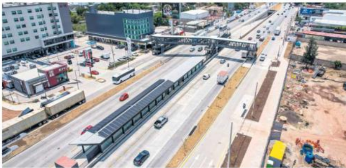
MOVILIDAD. Vista general de la estación Carretera a Chapala, de la Línea 5, nuevo sistema de conexión entre la terminal aérea y el transporte público metropolitano.
