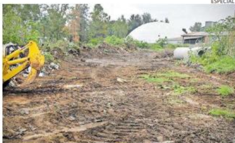
AHÍ EN MIRAVALLE. El nuevo tren de potabilización se construirá en un terreno dentro de la PP1; tendrá una capacidad de 2 mil litros por segundo.
