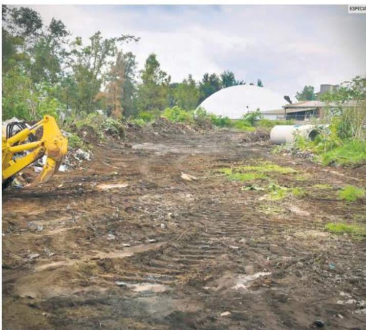
CONSTRUCCIÓN. La intervención es en respuesta al deterioro de la infraestructura existente, que tiene 70 años de operación continua y que de acuerdo con las autoridades ha cumplido su vida útil.
