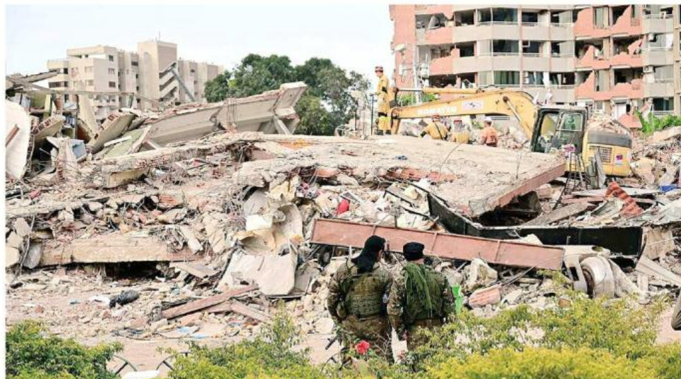
■ Autoridades venezolanas informaron que hasta ayer había 856 edificios afectados y 190 colapsados.
