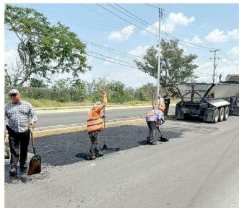
■ El Gobierno de Tlajomulco asegura destinar 60 toneladas de mezcla asfáltica al día para las reparaciones.
