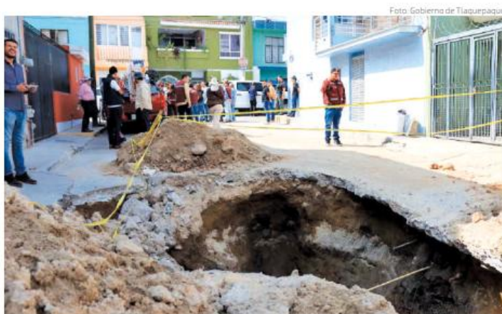
Repara Tlaquepaque socavón.
